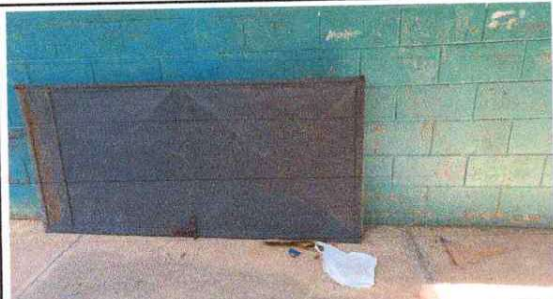
FOTO 1: Mantenimiento a estructura (lijado, cambio de tubo, cepillado, sujeciones, aplicación de pintura) PUERTA EN BAÑOS
