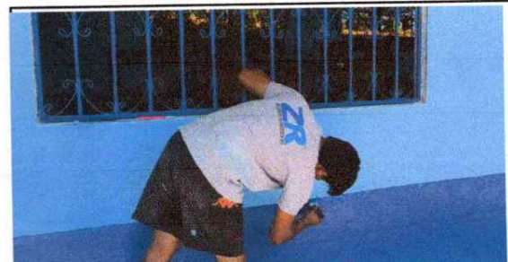
FOTO 6: Pintura en muros exteriores e interiores
