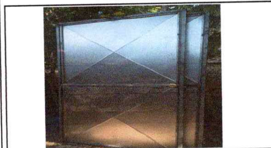
FOTO 5: Sustitución de puerta EN AULAS
